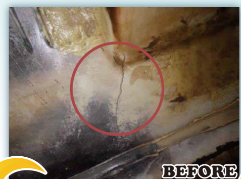
浄化槽内修理
